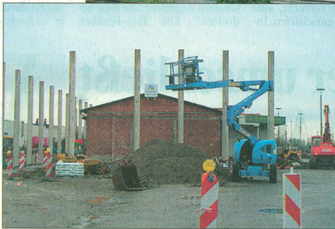
Die Pfeiler stehen, das alte Gebäude wird umbaut.
